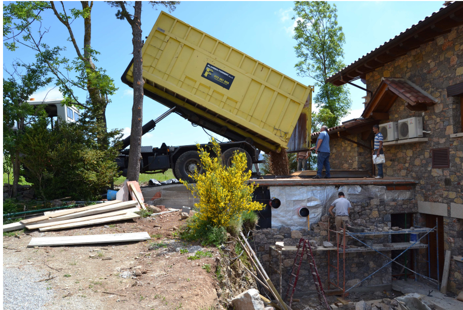
Exemple de subministrament d'Estella en sitja semi-soterrada
