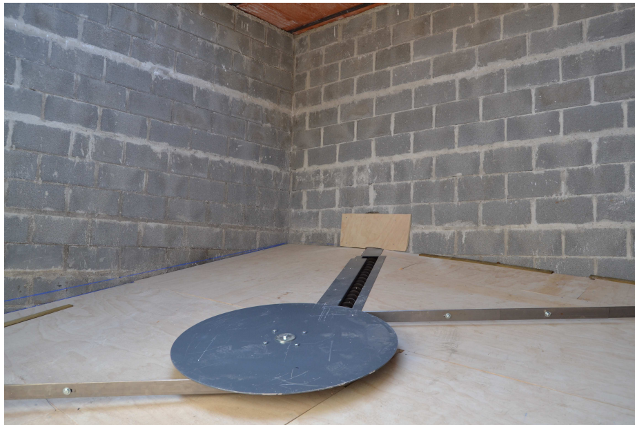
Exemple de subministrament d'Estella en sitja semi-soterrada
